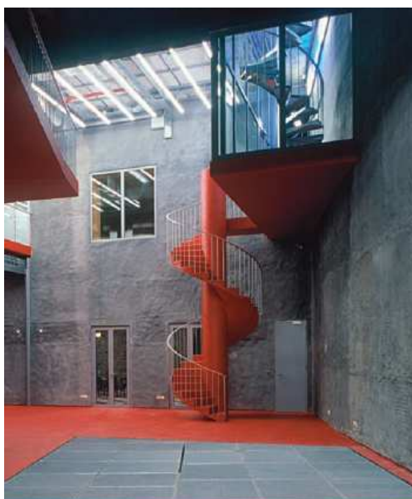
Le Beursschouwburg après sa profonde rénovation
